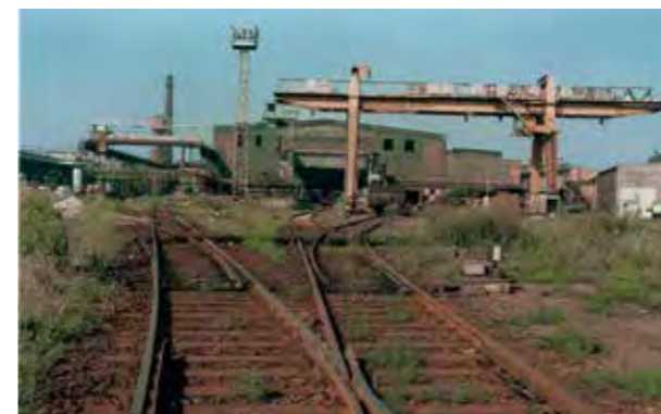
Blick auf das Gelände des ehemaligen Martinwerkes II (heutiges ESF-Gelände) zum Zeitpunkt des teilweisen Abbruchs der Werksanlagen (Foto vom 24.07.1992, Helmut Neumann)
