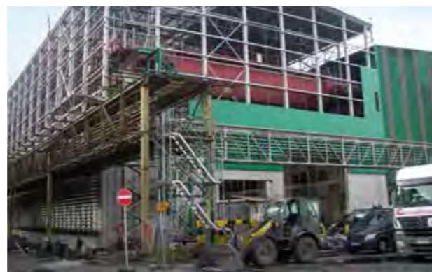
Weitere Einhausung Schrotthalle (Schallschutzbauweise) bis November 2011
