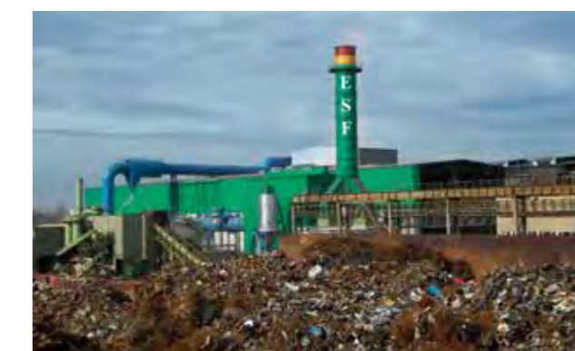
Darstellung der neuen zweiten Entstaubungsanlage mit Sammelleitung, Horizontalzyklon, Filterhaus, Kamin und Staubsilo: im Vordergrund die Kondiratoranlage
