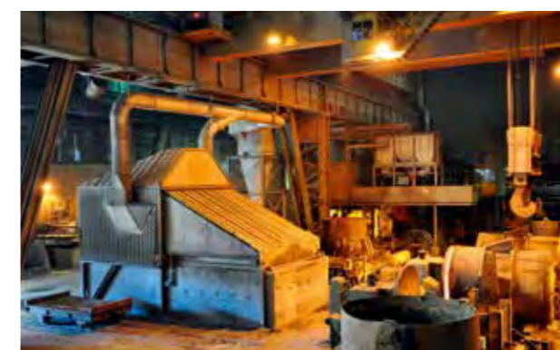
Installierte Absaughaube über der Schlackebox Pfannenschlacke in der Stahlwerkshalle
